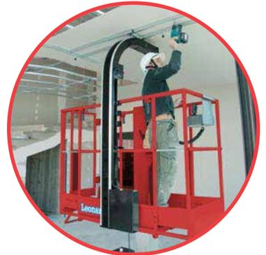
Activée directement avec un bouton sur la nacelle, la feuille se déplace jusqu'au bon endroit au-dessus de la tête de l'utilisateur, en le laissant travailler en toute sécurité.
